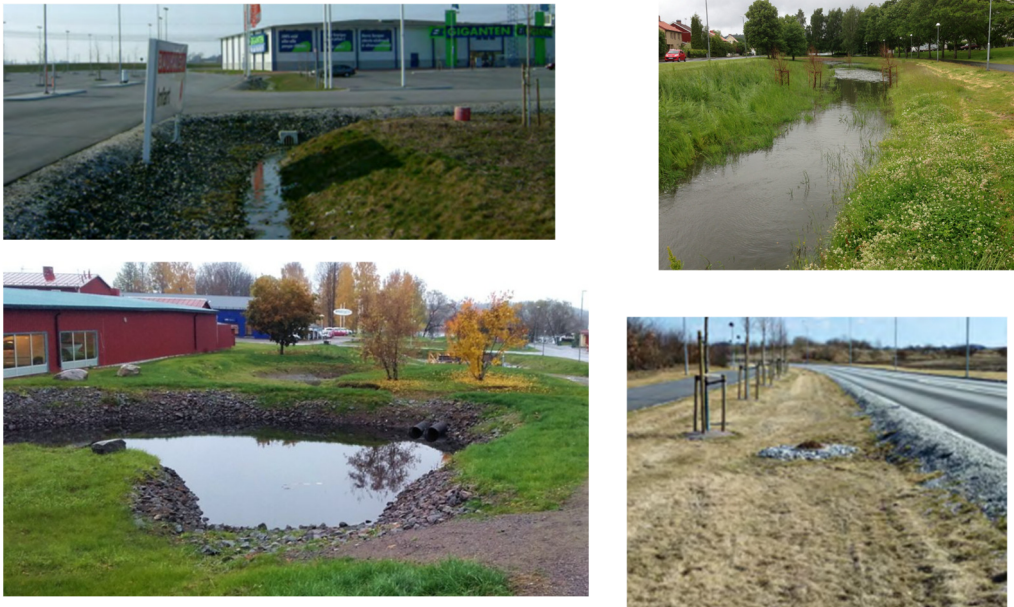
Figur 17: Avvattningsstråk/dike, samt fördröjningsdamm och svackdike. (källa projektbyggaren, Ljusdal wrs.se.)
