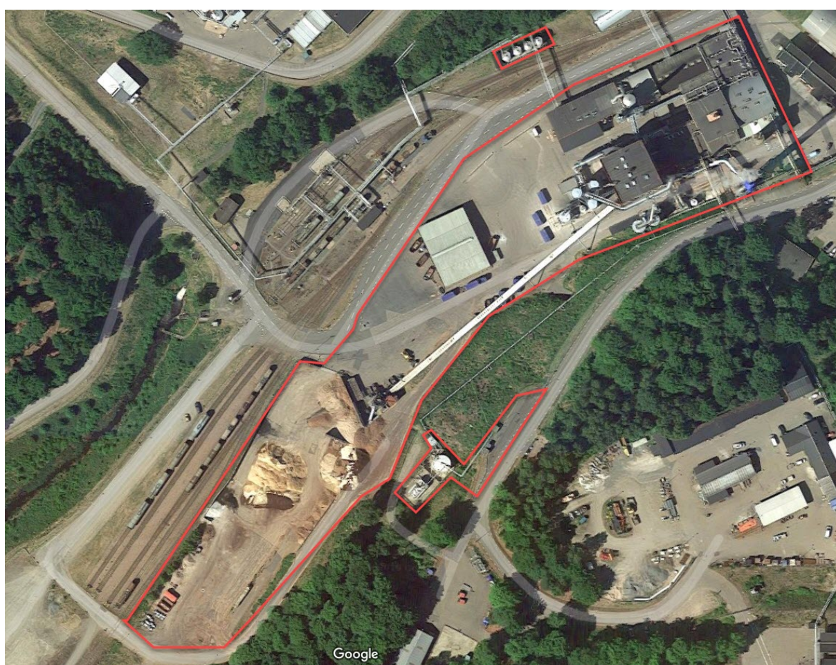
Figur 1. Verksamhetsområde för ångcentralen är markerat med rött. Överst i bild finns cisterner med bränsle till ångcentralen. Till höger i bild sker lossning av eldningsolja och natriumhydroxid samt lagring av eldningsolja. I den centrala delen ligger själva ångcentralen med tillhörande flisupplag.
