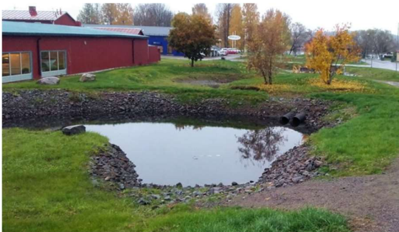
Figur 16: Avvattningsstråk/dike, samt fördröjningsdamm och svackdike. (källa projektbyggaren, Ljusdal wrs.se.)
