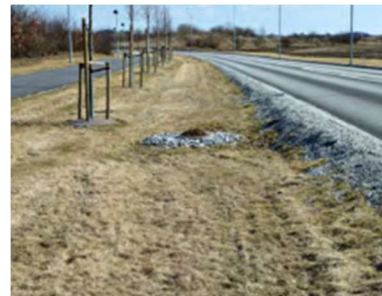
Figur 16: Avvattningsstråk/dike, samt fördröjningsdamm och svackdike. (källa projektbyggaren, Ljusdal wrs.se.)
