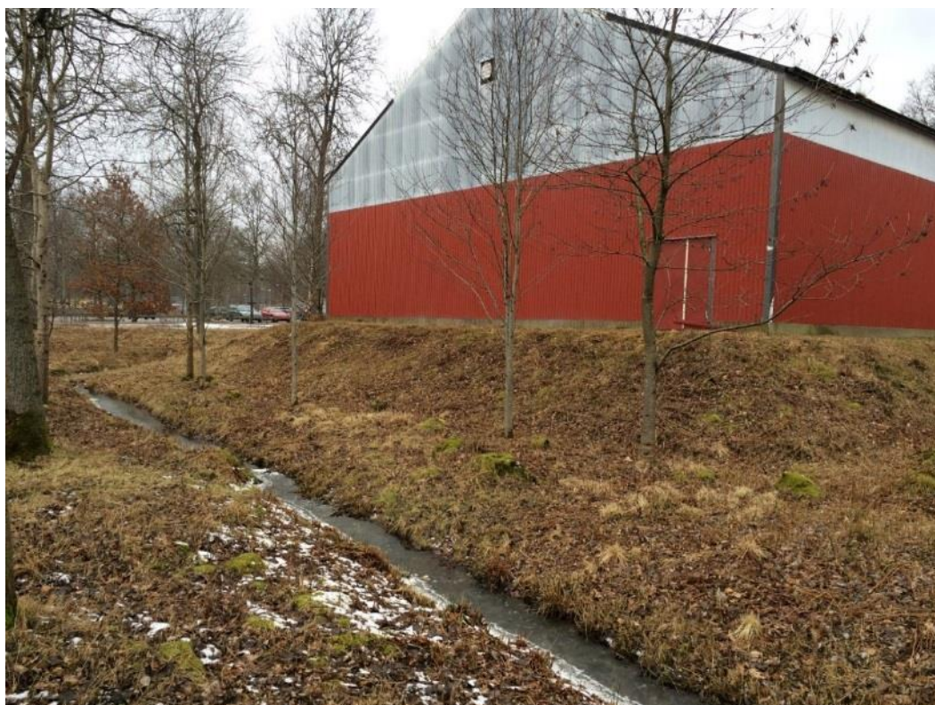
Bild över öppet dagvattendike söder om tennishallen.
