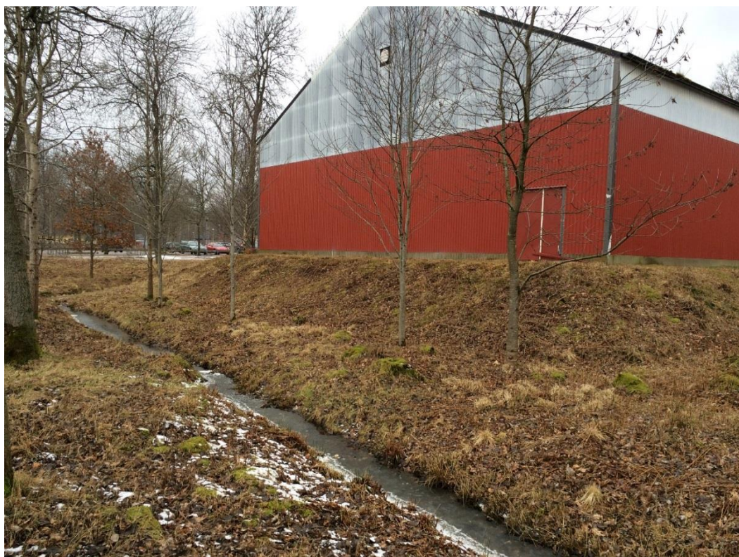
Bild över öppet dagvattendike söder om tennishallen.
